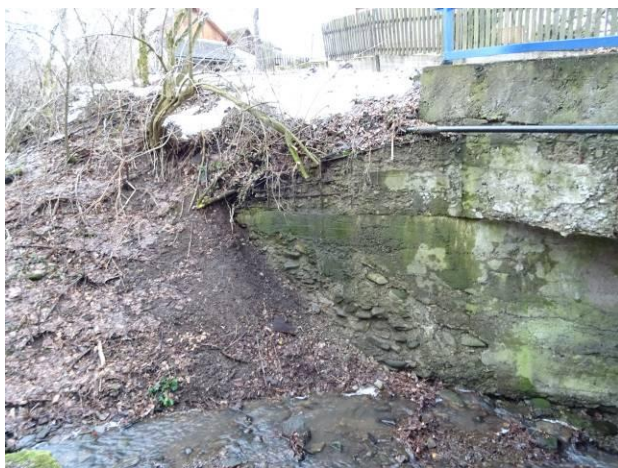
Křídlo K2L na vtoku.
