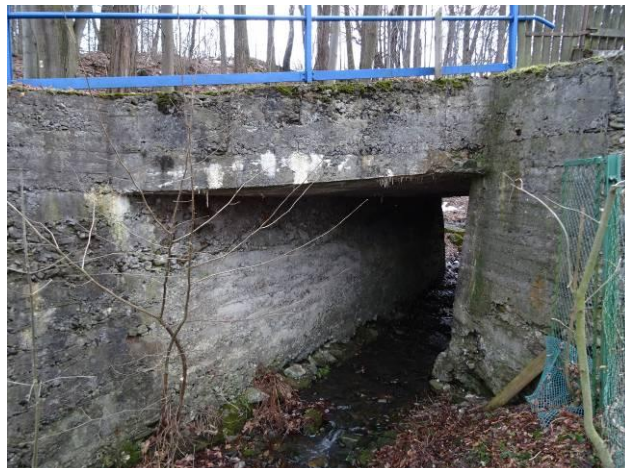
Mostní otvor – pohled na výtok.
