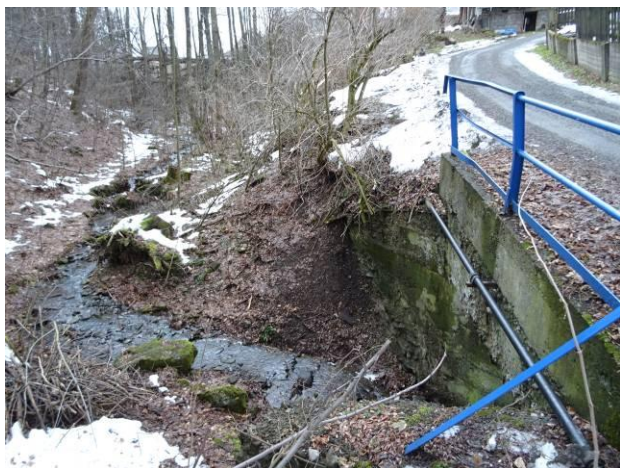
Pohled na vtok do propustku.
