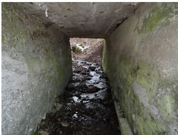
Pohld do mostního otvoru proti směru toku.
