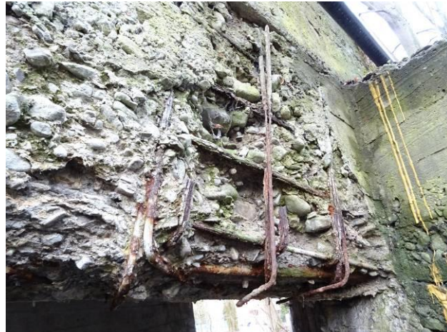
Detail levého boku nosné konstrukce před OP1.
