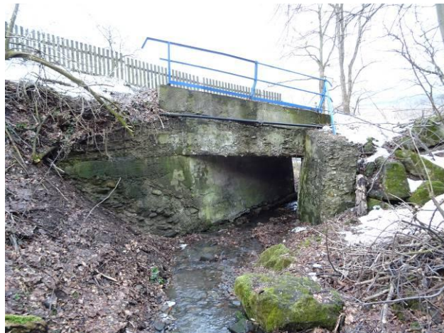
Pohled na propustek zleva od výtoku.
