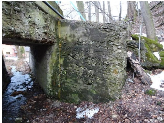
Křídlo K1L na vtoku.
