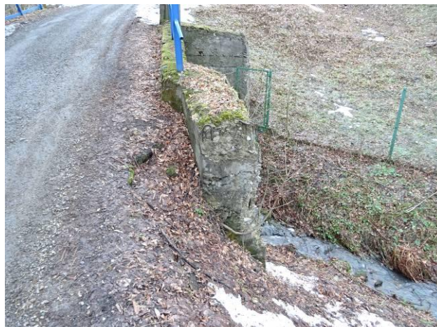
Čelo křídla K1P. Strmý svah u křídla.
