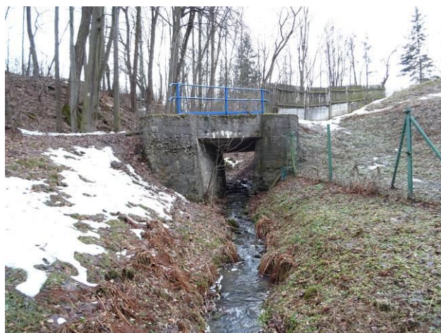
Pohled na propustek zprava od výtoku.
