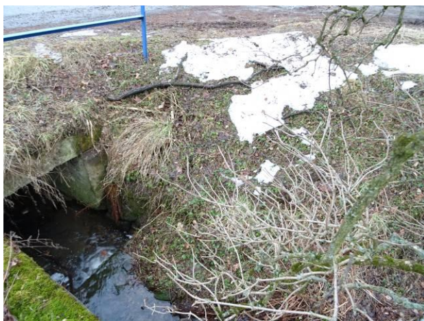
Pravý břeh před propustkem.
