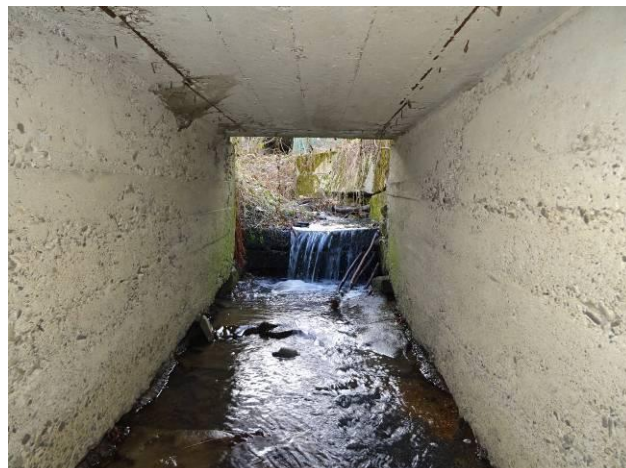
Pohled do mostního otvoru a na vodní stupeň před vtokem.
