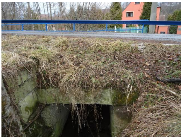
Pohled na vtok do propustku.
