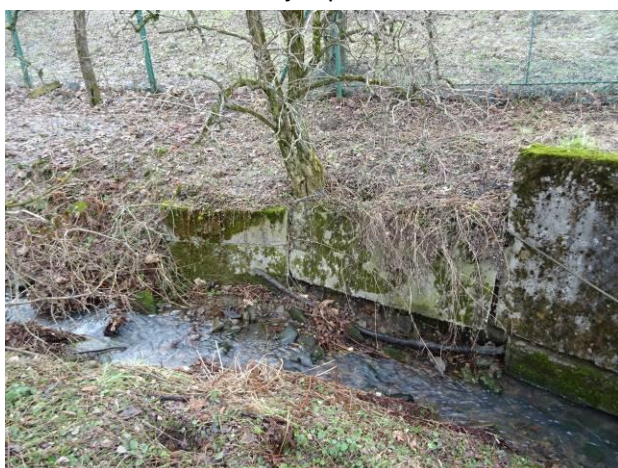
Opevnění levého břehu před propustkem.
