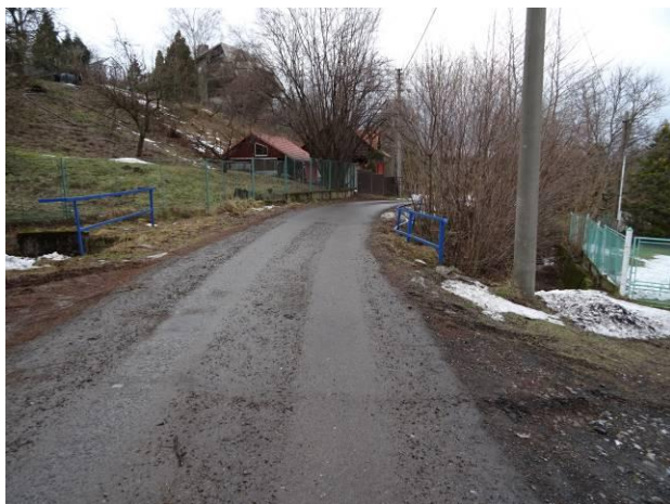
Pohled na propustek ve směru popisu. Vtok je vlevo.
