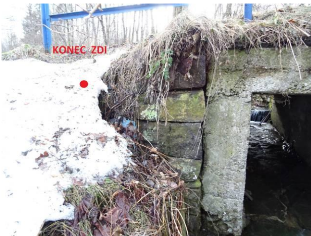
Pravé křídlo K1P opěry 1
