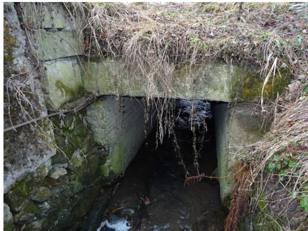
Pohled na mostní otvor na vtoku.
