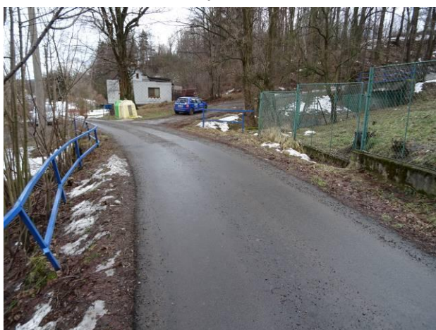
Pohled na propustek proti směru popisu. Vtok je vpravo.
