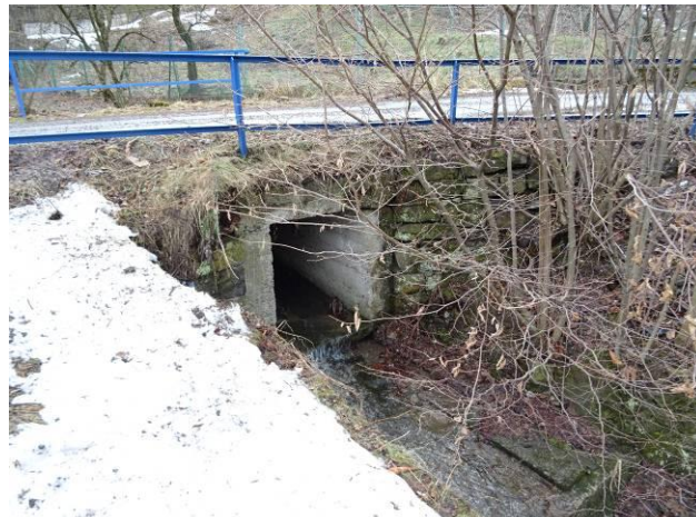
Pohled na propustek zprava od výtoku.
