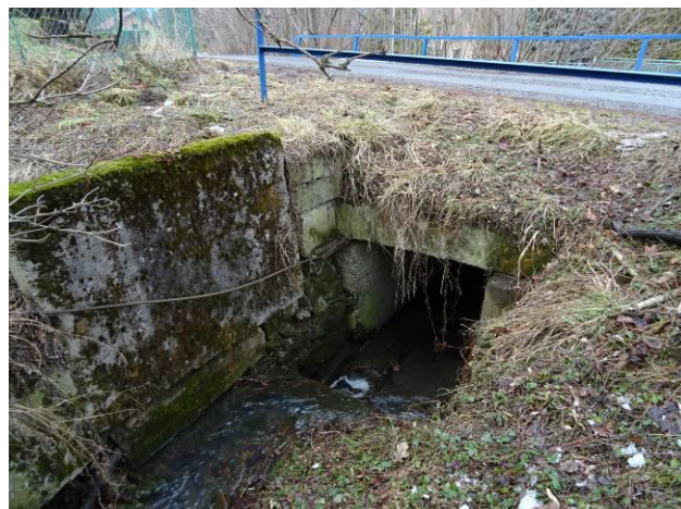
Pohled na propustek zleva od vtoku.
