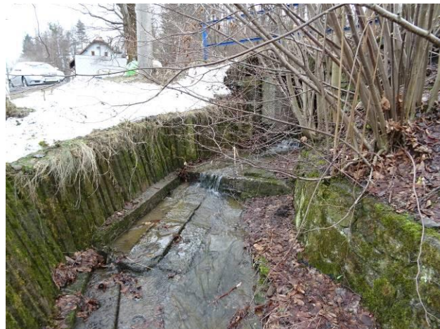
Opěrné zdi regulace potoku na výtoku.
