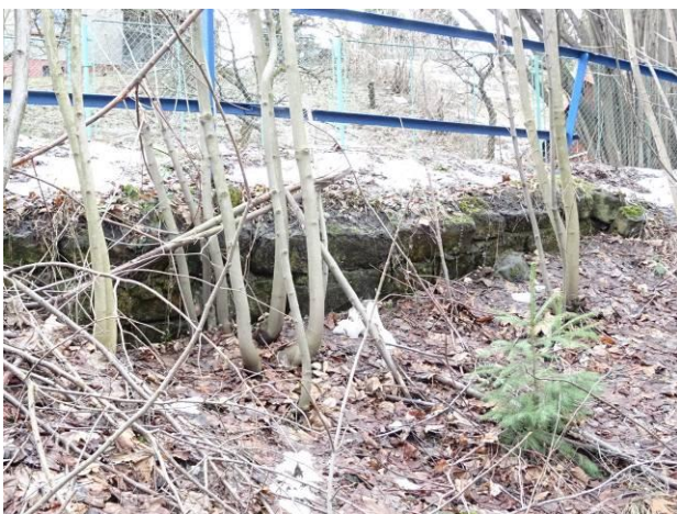
Nízká kamenná opěrná zídka navazující na křídlo K2P.
