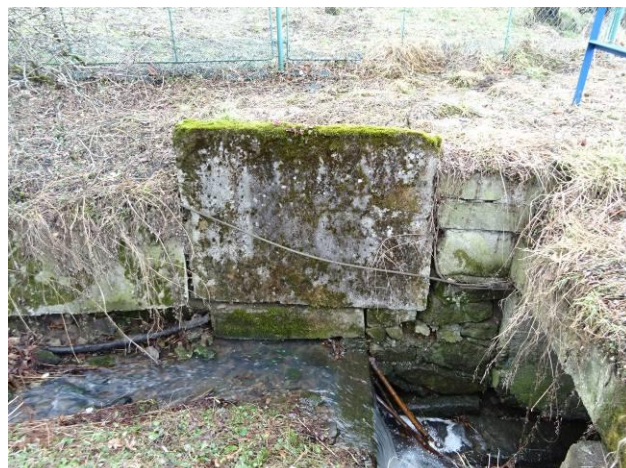
Opevnění levého břehu před propustkem.
